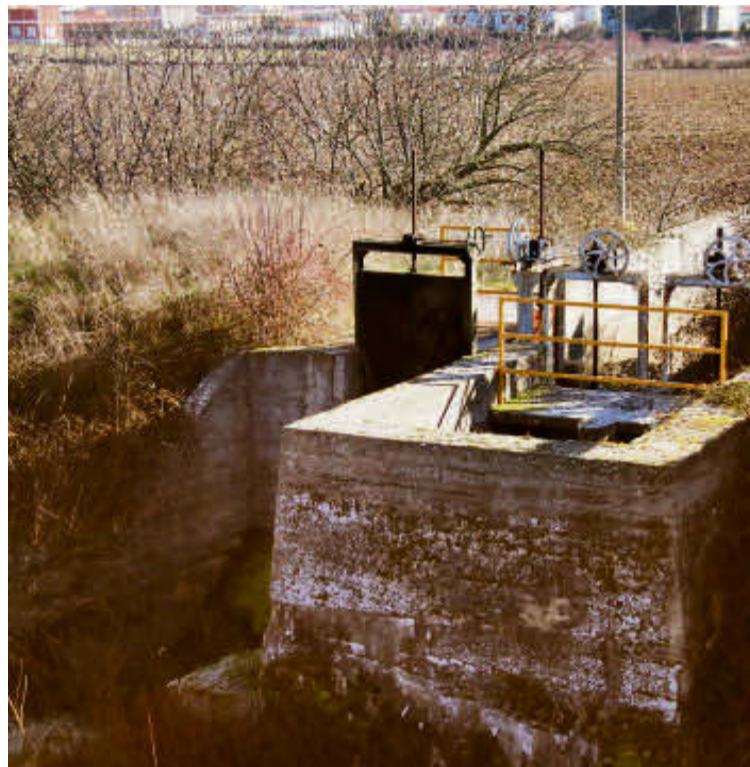
El Canal de La Maya será el primero en contar con placas solares. | ARCHIVO
